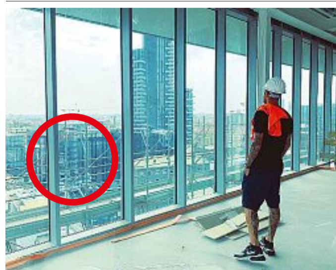
Icardi nel cantiere della nuova casa in zona Porta Nuova: eccolo mentre dà uno sguardo al panorama, che per puro caso include anche la sede dell'Inter, nel palazzo segnato con il cerchietto
